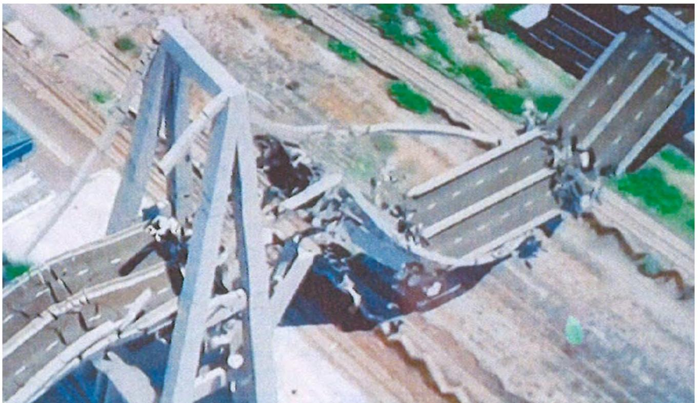
Simulazione rottura dei 4 stralli, collasso del ponte pila 9 integra
